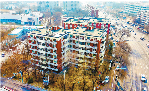
近日,红桥区芥园街立兴里、清水楼、桃园里小区提升改造完毕。此次提升改造不仅让老小区整洁亮丽,而且更有效提升建筑的保温隔热性能,为居民营造冬暖夏凉的居住环境。
