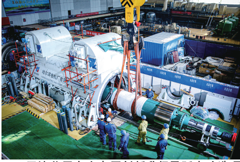
天津公司盘山电厂创新升级及延寿改造项目1号发电机穿转子工作顺利完成。
