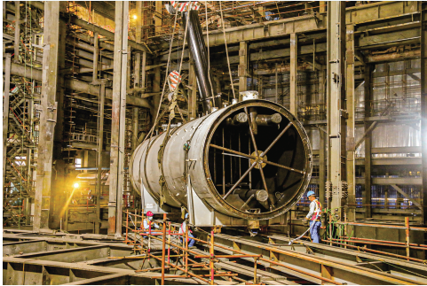
天津公司盘山电厂创新升级及延寿改造项目1号机组除氧器吊装就位。
