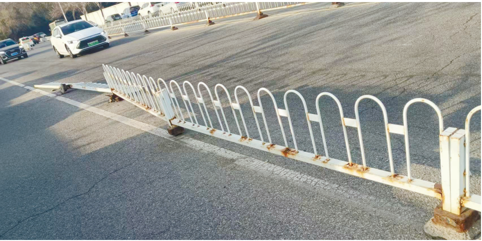
凤展道隔离护栏损坏、缺失、倾倒。
