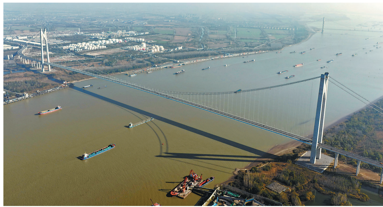
11月26日,南京新生圩长江大桥建成通车。据悉,南京新生圩长江大桥是南京主城连接江北新区的重要枢纽,项目全长约13.17公里,主线设计时速80公里,双向六车道。该桥的通车对提升南京长江干线过江能力、完善区域路网体系具有重要意义。 新华社发
