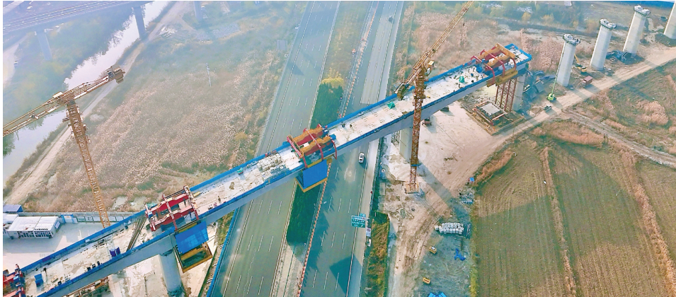
近日,京滨城际铁路滨海特大桥跨秦滨绕城高速连续梁顺利合龙。滨海特大桥横跨滨海新区与东丽区,全长14.597公里。京滨城际铁路全线通车后,滨海新区至北京城市副中心将快速通达。
