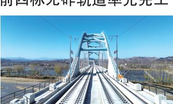
近日,由雄安高速铁路有限公司建设、中铁十八局局承建的雄忻高铁河北段站前四标无砟轨道工程顺利完工,成为全线率先完成无砟轨道施工的标段,为后续铺轨作业和实现2027年全线通车目标奠定了坚实基础。
