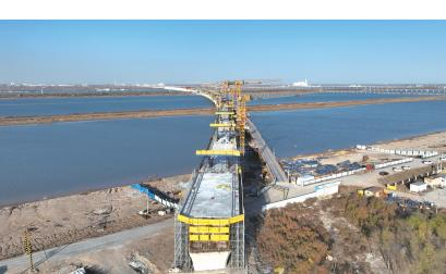
近日,中国铁建大桥局承建的津潍高铁天津段又有新进展,跨独流减河刚构连续梁均进入合龙段施工,正在依次合龙,该段全长1314米,由于位于河道内施工难度较大,是全标段的重点管控工程,预计12月中旬进行最终的中跨合龙。
