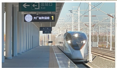
▲北京城市副中心站。 ▶正在试运行的动车组列车。 记者 张磊 摄
