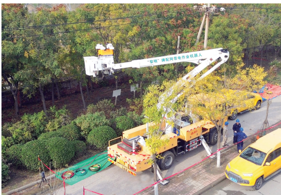
新一代国产双臂配网带电作业机器人作业现场。 通讯员 孙晓岚 摄
