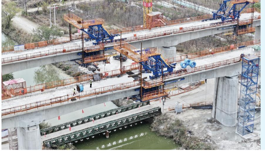
昨天,由中铁十八局承建的津潍高铁天津枢纽工程津潍、京滨下行联络线特大桥上跨黑猪河连续梁顺利合龙。这条枢纽联络线建成后,可实现津潍高铁与京滨、津秦高铁的互联互通,加速提升京津冀城际铁路运力。
