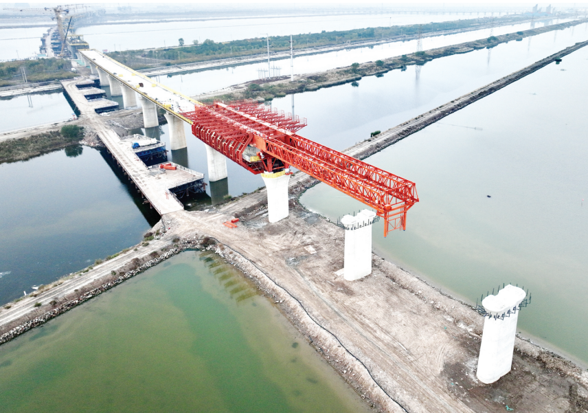
昨天，中铁建大桥局在滨海新区完成津潍高铁全线唯一采用移动模架工艺施工的现浇梁浇筑，实现了“空中造桥”。 记者 张磊 摄
