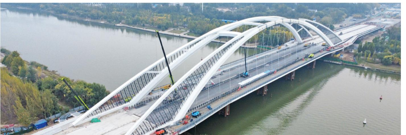
日前,天津海河柳林“设计之都”核心区综合开发PPP项目柳林桥工程主桥完成全部钢桥面铺装施工。
