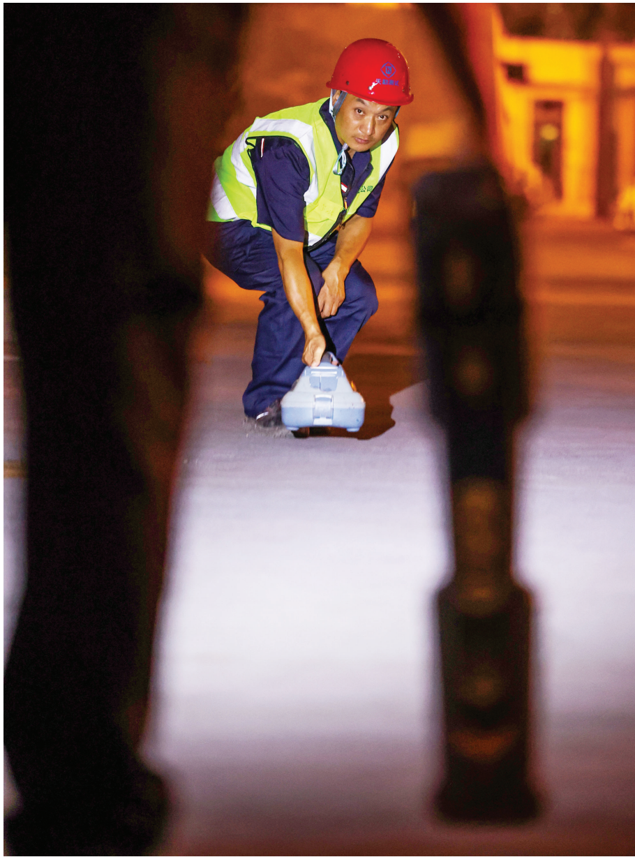
利用管线仪排查路面下的管线情况。
