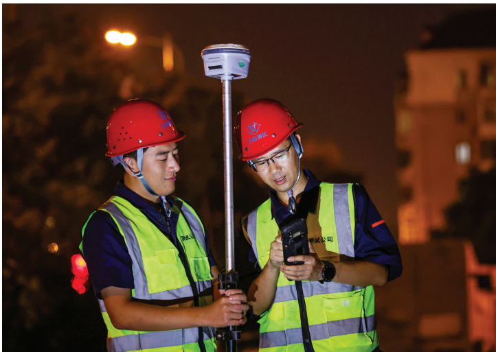
利用GPS设备为病害点精确定坐标。
