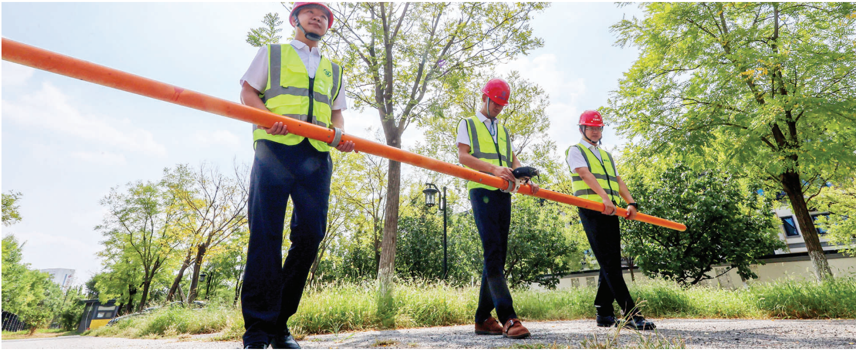
通过电磁三维成像设备对存水量较大的区域进行检测。
