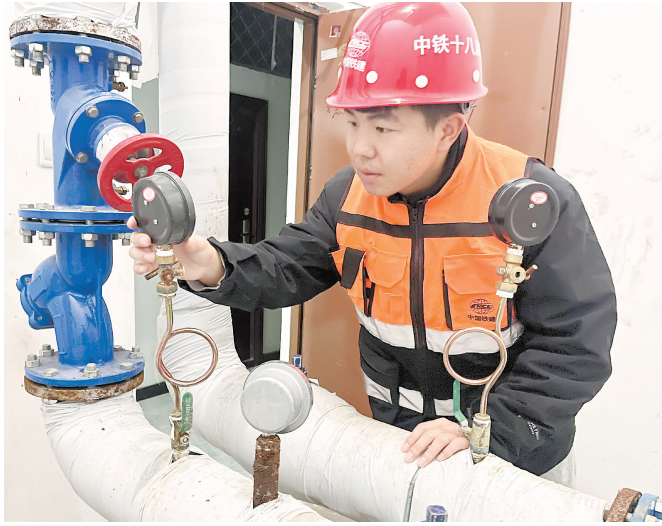
连日来,中铁十八局北京公司工作人员在天津临港中欧蓝白领公寓项目开展实时供热状态监测,对公寓的压力表、阀门、循环泵等关键供热设备进行多轮次排查,发现问题即刻维修,确保今冬供热系统稳定运行。
