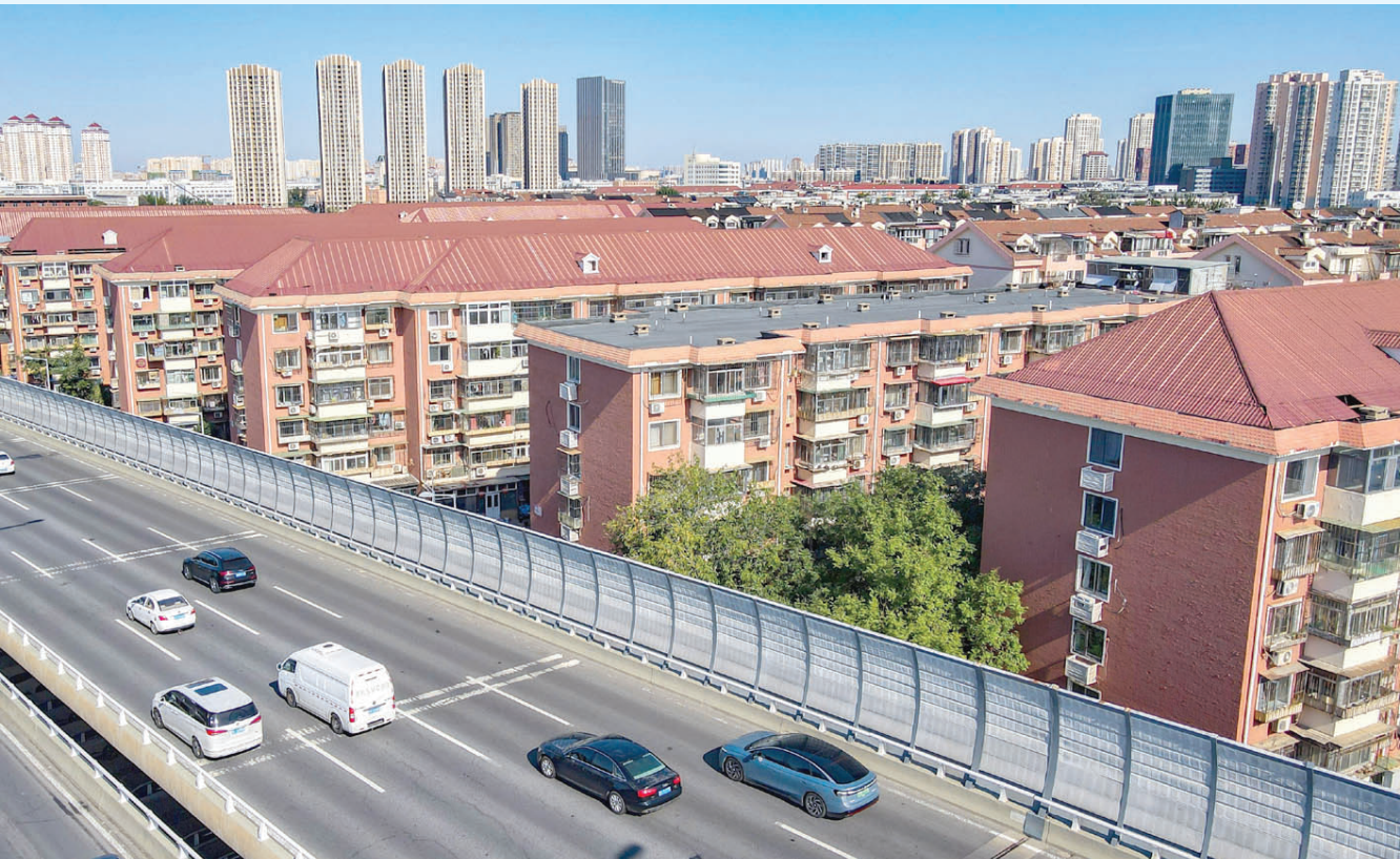
日前,位于快速路西北三环云河桥至简阳路段、累计长度1525米的隔音屏全部安装完成,涉及雅润嘉园、绿水园、鹤园南里等区域,为沿线居民营造安静的居住环境。 记者 吴迪 摄
