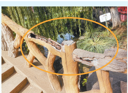
人造拱桥栏杆扶手钢筋裸露在外。
