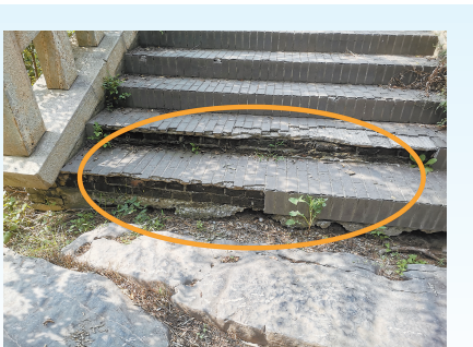
桥面砖块破损。
