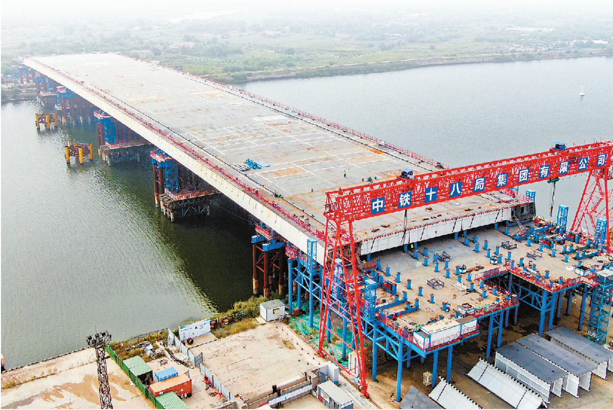
昨天,由中铁十八局承建的滨海新区西中环快速路跨海河桥12500吨的钢箱梁顶推就位。
