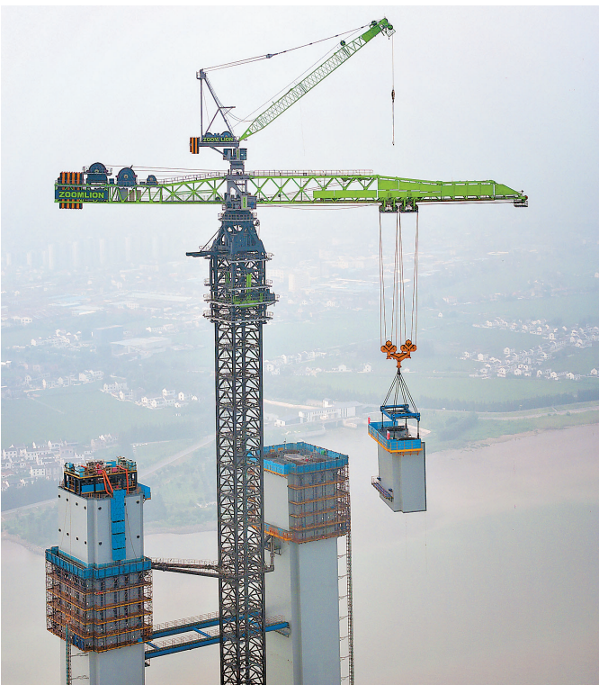
14日,连接江苏省苏州、泰州和南通的张靖皋长江大桥南航道桥南主塔顺利完成第26个节段吊装,主塔升至300米的新高度。 新华社发
