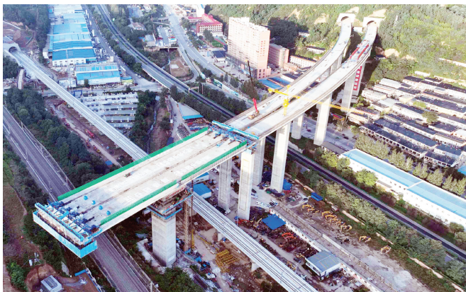
图为南泥湾机场大桥转体施工现场。 中铁六院供图
