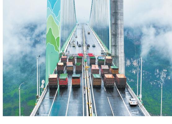
新华社贵阳8月21日电(记者 欧东衢 向定杰)21日,随着18辆总载重630吨的卡车分批行驶上桥,停放在预先划定的停靠点,在建世界第一高桥——贵州花江峡谷大桥正式启动荷载试验。
