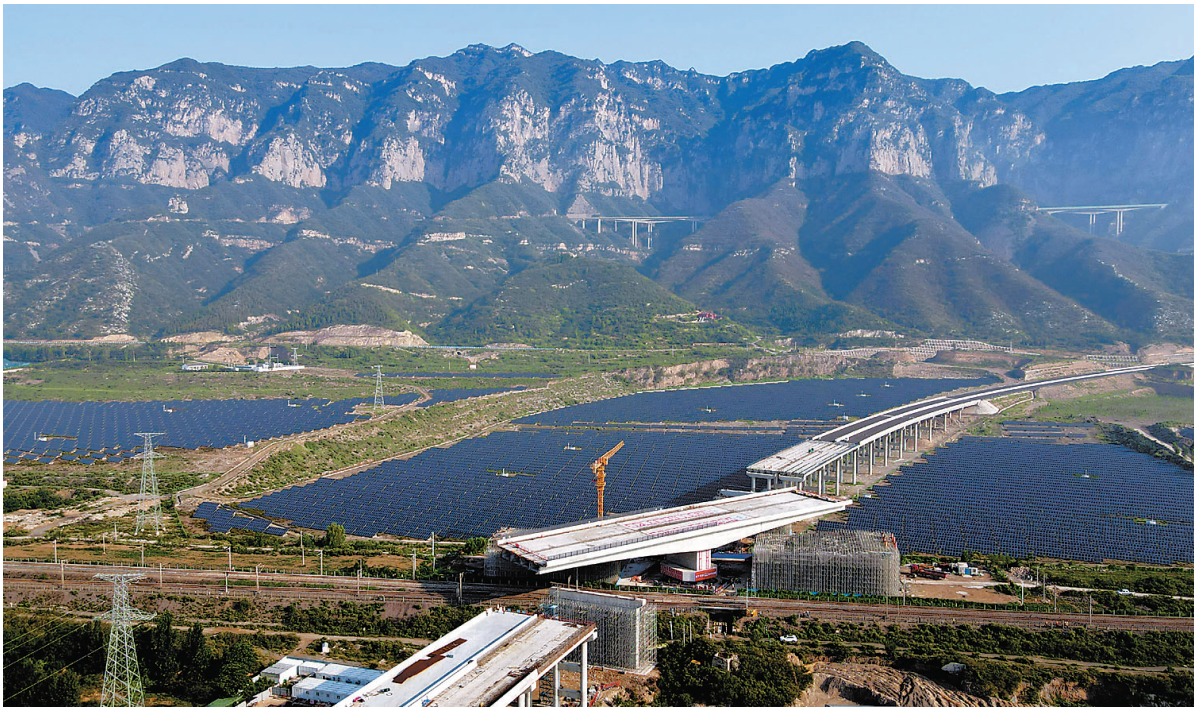
8月11日,由中铁大桥局承建的河南省济源市沿太行山高速公路上跨焦(作)柳(州)铁路立交桥成功转体。转体主梁总长130米,总重量达2.1万吨。图为转体施工现场(无人机照片)。
