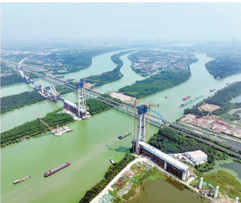
这是8月5日拍摄的沪渝蓉高铁跨京运河河斜拉桥建设现场(无人机照片)。当日,由中国铁建大桥局承建的沪渝蓉高铁跨京运河河斜拉桥主塔顺利封顶。至此,大桥核心支撑结构施工圆满收官。该桥位于江苏扬州境内,是沪渝蓉高铁全线关键控制性工程,桥长564.3米,主跨300米。
