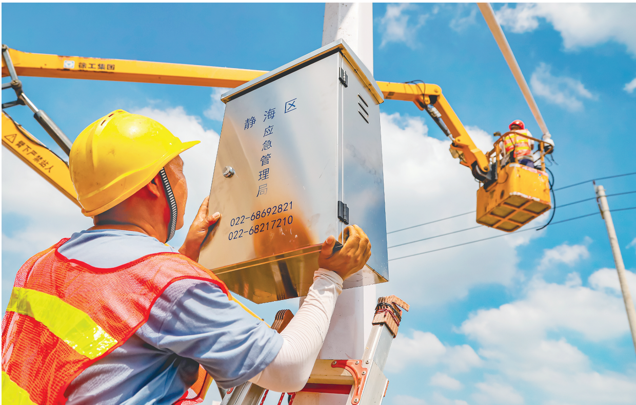
连日来,静海区应急管理局智慧防汛应急系统提升改造项目加快推进,对全区 42 个下沉式地道涵洞以及 50 个低洼易积水点位加装防汛智能感知监控前端设备,进一步强化险情处置的及时性和精准性。
