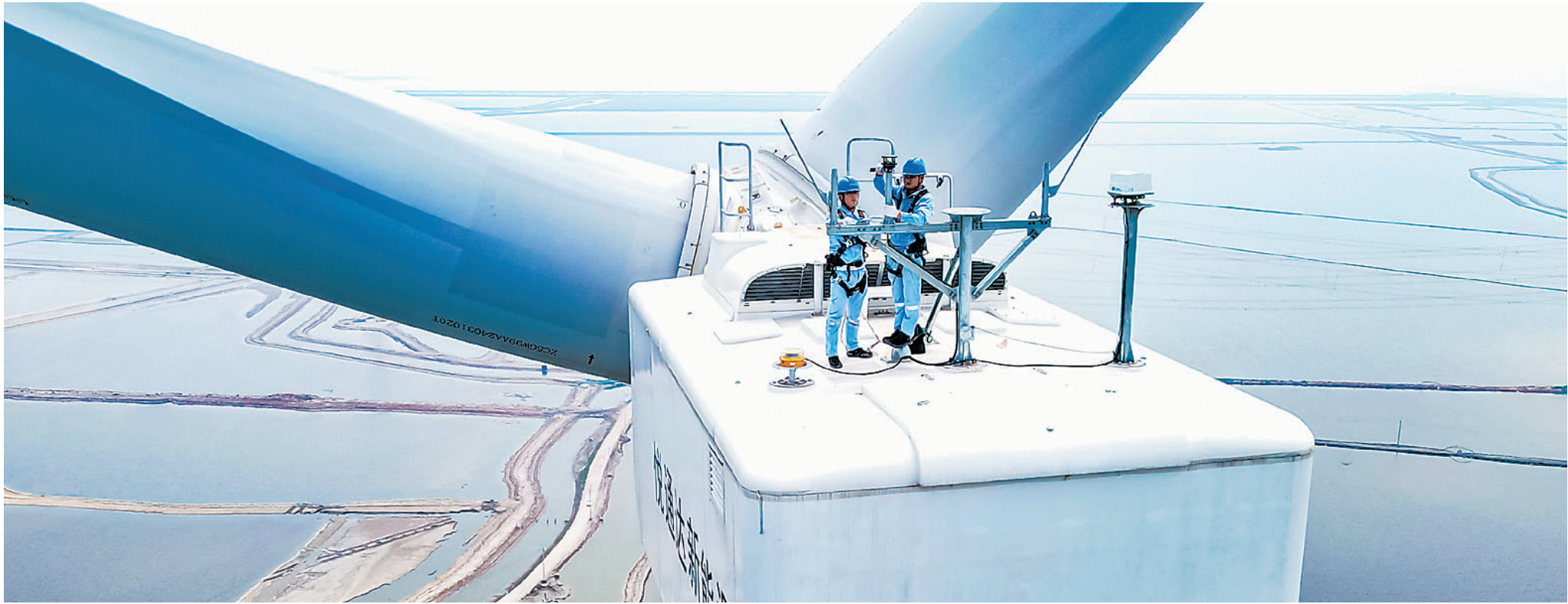
位于滨海新区寨上街的天津汉沽悦通达44.48MW分散式风电项目加强夏季巡检力度,工作人员采用热成像等技术手段精准掌握设备运行状态,并结合箱变滤网和风机散热器滤网的清理,确保箱变和风机通风良好、运行稳定。
