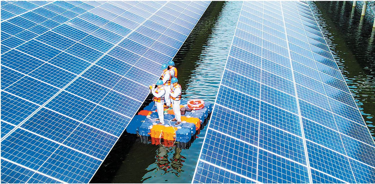
为保障光伏电站夏季运行安全,金开新能源股份有限公司天津西青大寺镇诚开120MW光伏项目现场,运维人员顶着烈日进行红外测温 and 杂草清理等工作,全力保障绿色电力持续稳定输出。
