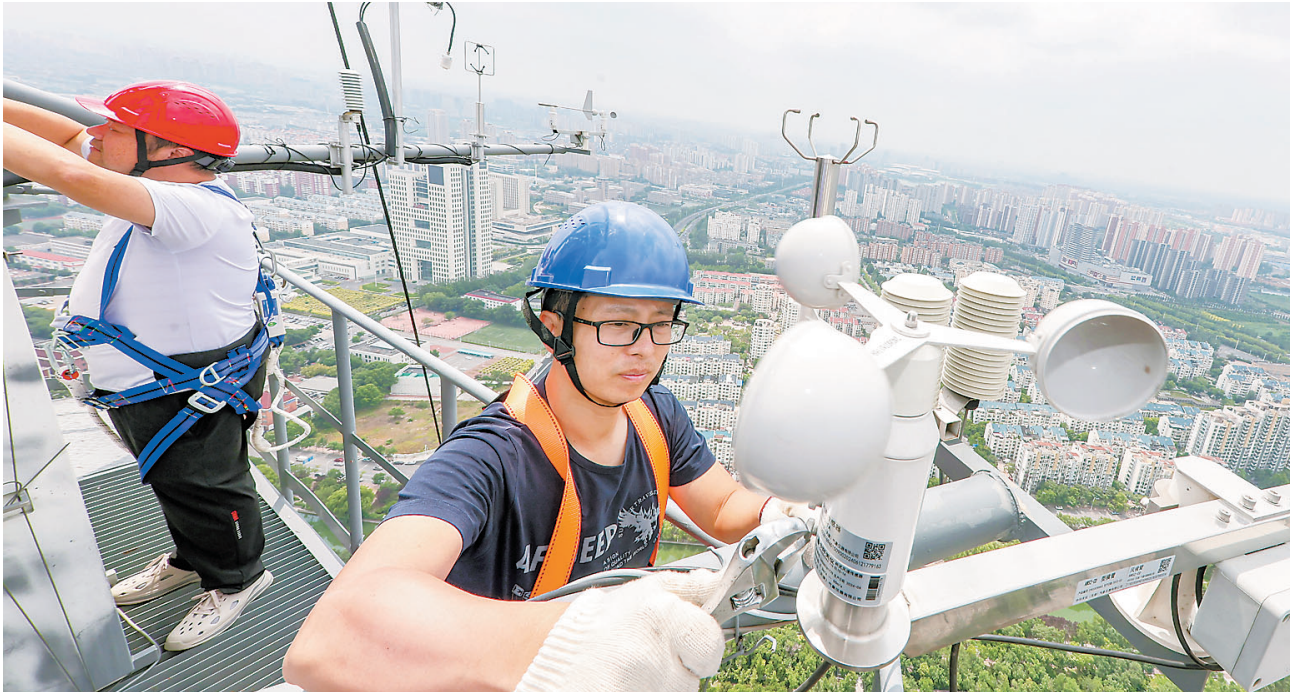
友谊南路天津气象雷达研究实验中心院内255米高的气象观测塔上,十余种近百个监测设备用于我市大气边界层的气象和环境监测。烈日下,工作人员对铁塔的电力、监测仪器、通信设备等进行日常维护,确保监测数据的科学准确。
