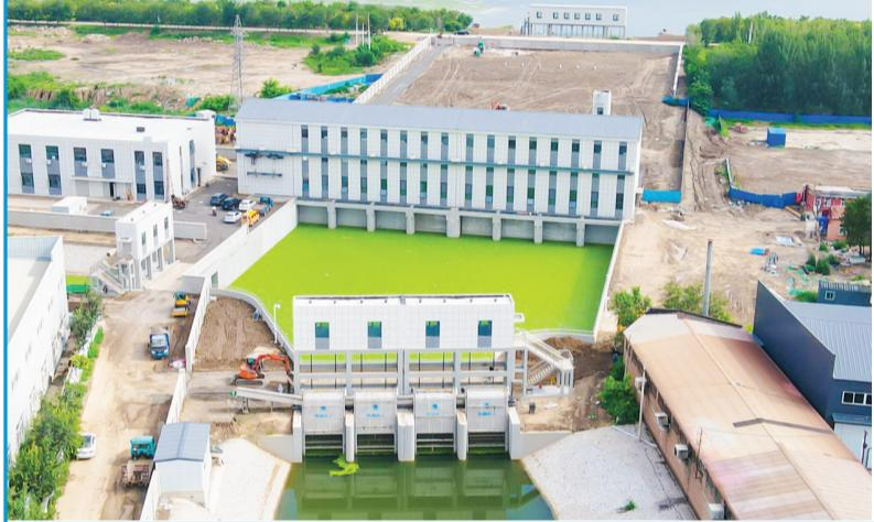
日前,静海区良王庄泵站改扩建工程历经一年多的紧张建设已正式完工投用。泵站位于静海运东排干与独流减河交口处,改扩建工程更新了机电设备、金属结构设备,新增了自动化系统、观测设施及其他必要的运行管理设施,改扩建后的良王庄泵站成为一座以排涝为主,兼顾生态补水的综合性泵站,为保障人民群众生命财产安全和区域经济发展筑牢安全屏障。
