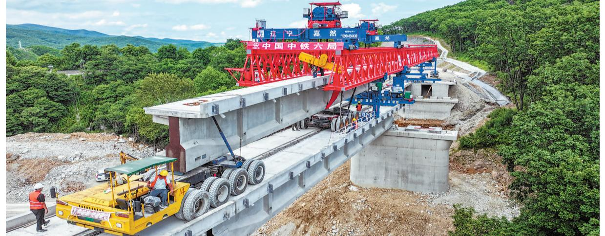
7月20日,滨绥铁路绥芬河至国境线提质改造工程绥芬河特大桥完成全部T梁架设,为后续线路铺设奠定了坚实基础。
