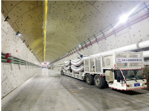
预制完成的管片运抵津潍高铁津沽海河隧道准备进行施工作业。 照片由中铁十四局房桥公司提供
