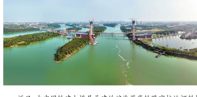
近日,由中国铁建大桥局承建的沪渝蓉高铁跨京杭运河斜拉桥主桥两岸钢混段架设顺利完成,大桥主桥上部结构施工转入钢梁悬臂拼装阶段,主塔建设已完成90%。这是沪渝蓉高铁跨京杭运河斜拉桥施工现场(7月13日摄,无人机照片)。
