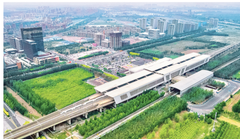
天津南站科技商务区。
