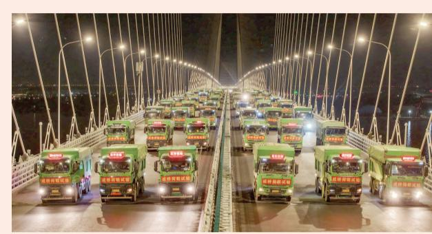
6月20日晚,常泰长江大桥主航道桥进行4400吨荷载试验,110辆重型卡车驶上主航道桥面,启动静态荷载试验。自6月16日起,常泰长江大桥开启为期一周的荷载试验,对大桥承载力和安全性进行全面评估。
