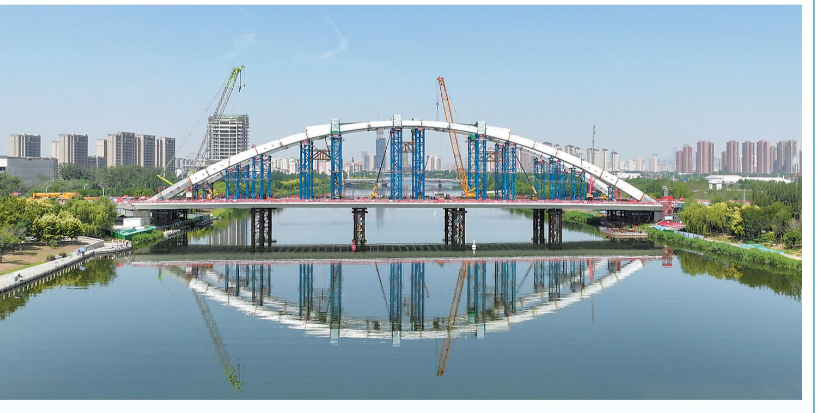
昨天，柳悦桥主拱合龙，该桥总长204米，位于春意桥与吉兆桥之间，横跨海河，设置双向6车道及非机动车道、人行道，预计今年年内全面竣工。
