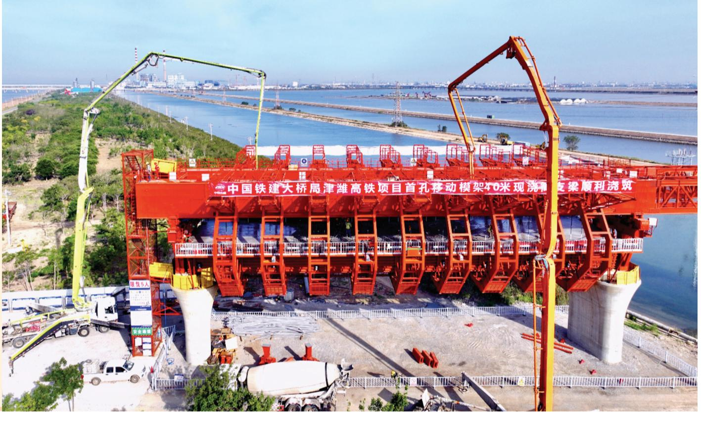
近日,由中铁建大桥局承建的津潍高铁项目首次采用移动模架施工完成水上连续梁首联浇筑。采用移动模架施工较传统架梁模式增加了施工稳定性,同时可以有效降低水上施工的风险,加快施工进度。
