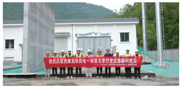
5月27日,中铁十二局集团电气化公司西康高铁四电一标顺利完成首台牵引变压器安装。 通讯员 张一星
