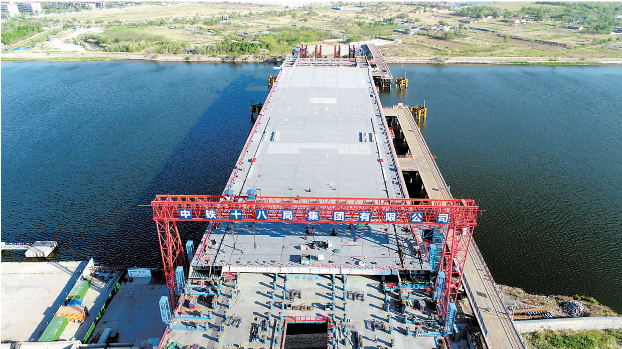
“五一”假期,中铁十八局滨海新区西中环快速路跨海河桥工程施工人员坚守一线,目前主桥钢梁顶推任务已经过半,预计7月底全部完成。
