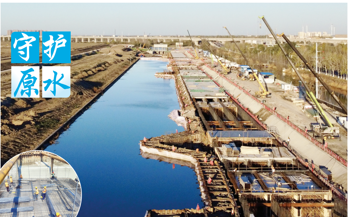
由中建六局水利水电电公司负责施工的引滦原水预处理厂工程(第3标段)已完成明渠改造暗渠的施工，并具备引滦、引江双水源的通水要求。 项目位于宝坻区尔王庄水库东南侧引滦明渠上，通过为去除原水中藻类和2-甲基异莰醇等，为后续水厂处理提供优质原水。 记者 张磊 摄
