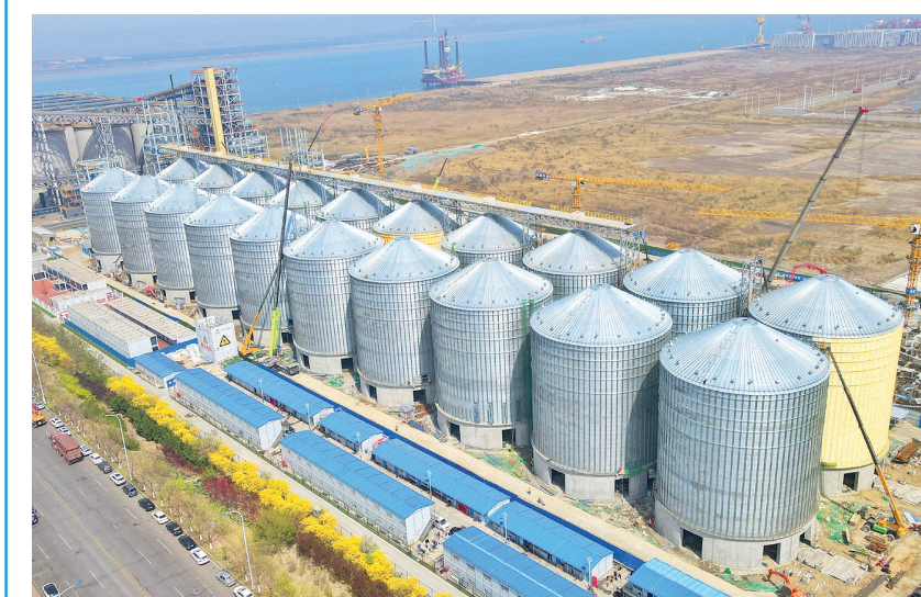
日前,作为天津港口型国家粮食物流核心枢纽建设重要项目,保税区临港现代粮食物流产业园区粮食仓储物流集散中心项目的20座单体1万吨粮食钢筒仓主体全部完工,预计年中投用。项目建成后,将全面提升天津临港区域粮食仓储能力,为粮食安全和京津冀粮食保供提供坚实保障。
