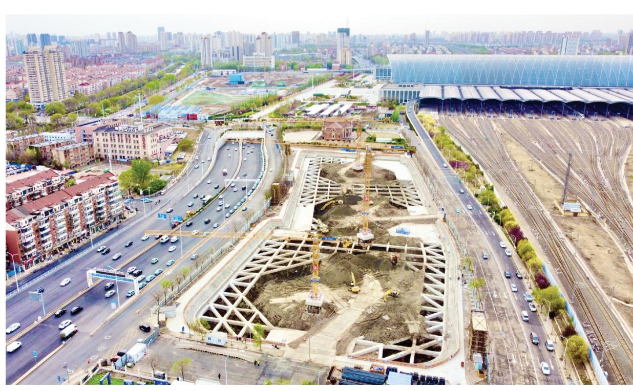
西站东山姆四代旗舰店项目正在紧锣密鼓地施工。自2024年8月全面开工以来,截至目前,已完成桩基工程,正在进行基坑支护工程、土方工程施工,实施现场围挡整治提升工程。项目预计今年年底主体竣工,2026年9月底正式开业。
