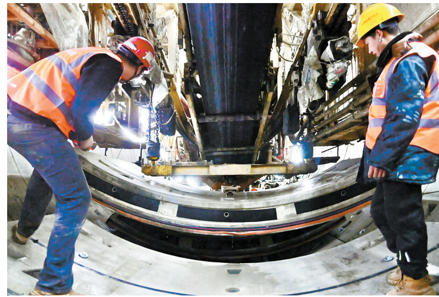
地铁8号线延伸线已进入盾构施工阶段。昨天,中国铁建大桥局施工人员在工程建设现场开足马力奋战“开门红”。 本报记者 张磊 摄
