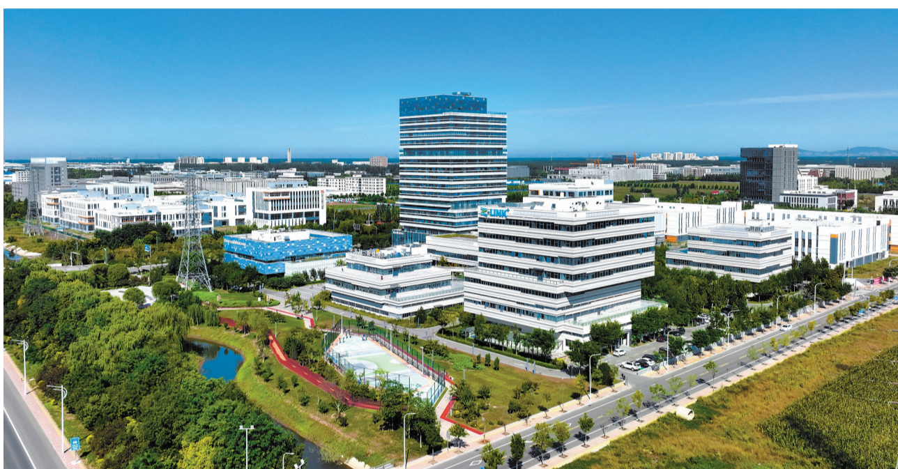
天津中关村科技城项目进展迅速。
