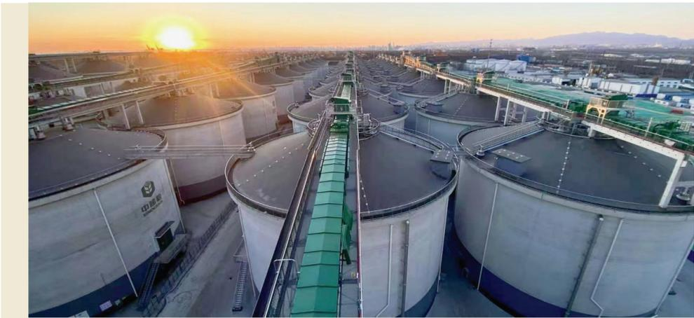
由驻津央企中建八局承建的中央储备粮秦皇岛直属库有限公司海港粮食储备基地项目(三期)即将投入使用。项目位于河北省秦皇岛市,包含30座浅圆仓,总仓容量24万吨。该项目是服务国家粮食宏观调控、保障京津冀粮食供应、维护国家粮食安全重点建设工程。
