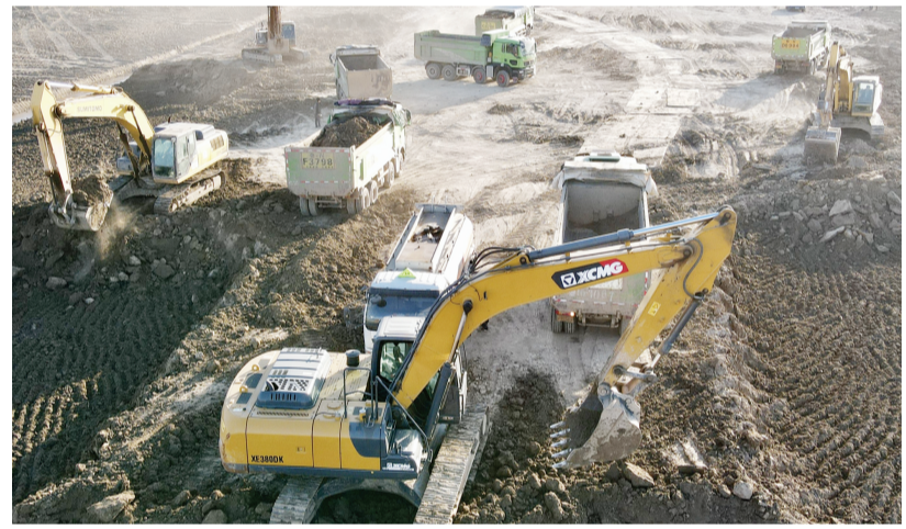
新年伊始,驻津央企中铁十八局近百名建设者奋战在静海区大口洼滞洪区工程现场进行灌注桩作业,全力推进工程进度。 本报记者 张磊 通讯员 段一鸣 摄
