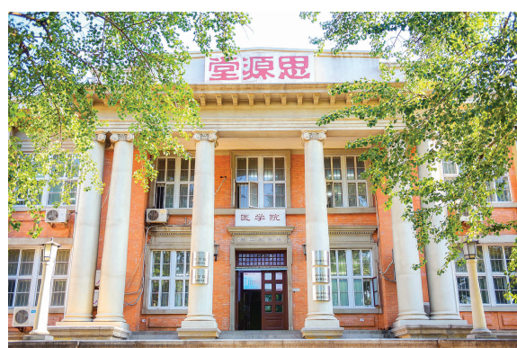
1923年建设的思源堂。1937年,日寇轰炸南开大学,木斋图书馆、秀山堂等多处建筑被毁,唯有思源堂幸存。
