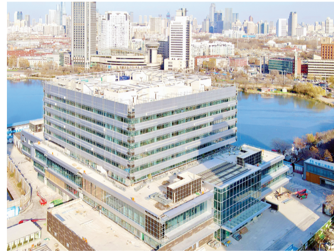
由中建三局承建的天津市环湖医院原址改扩建工程外檐施工正在紧张进行,春节前将全部完成,并于明年交付使用。届时将打造全国知名的环湖神经学科特色品牌,提升我市疑难复杂神经科疾病的诊断治疗、科研创新、预防和康复水平。
