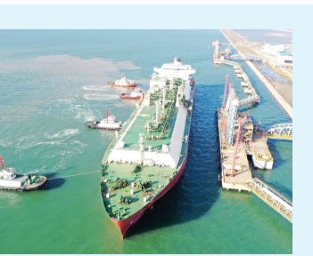
12月13日,满载6.5万吨液化天然气的“江南”号LNG船顺利靠泊国家管网集团天津液化天然气有限责任公司码头,为京津冀地区供暖提供坚实保障。
