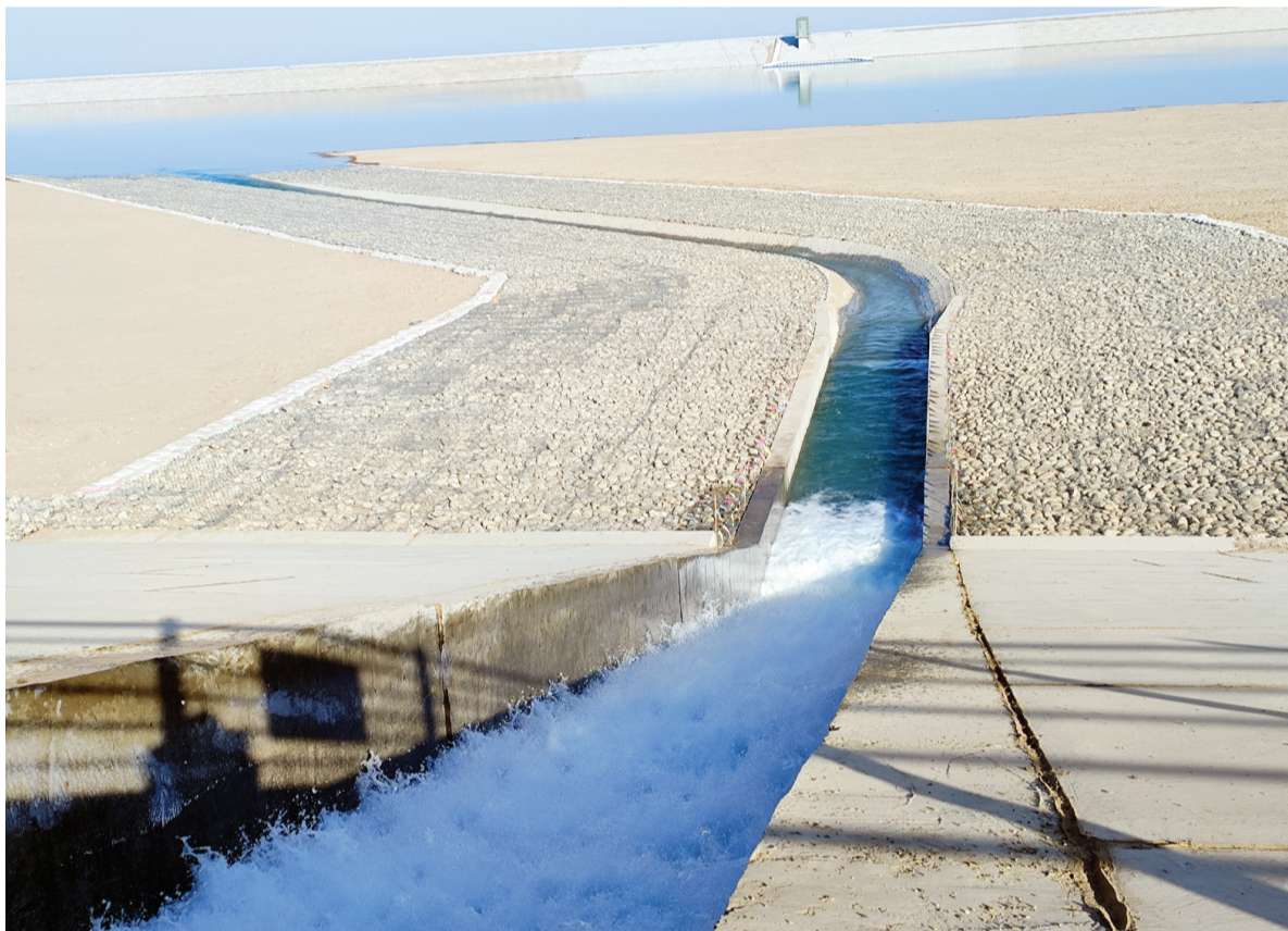
在塔克拉玛干沙漠南缘,由天津企业参与监理的和田地区墨玉县玉西开发区场外输水工程正在蓄水,该工程将于2025年全部投用,届时可灌溉农田面积达15万亩。
