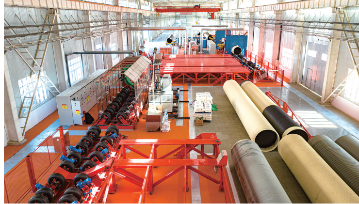
太合公司保温管技术研发生产基地车间
