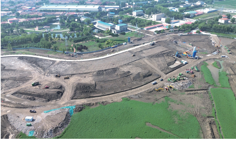
尔王庄水库增容工程项目现场
