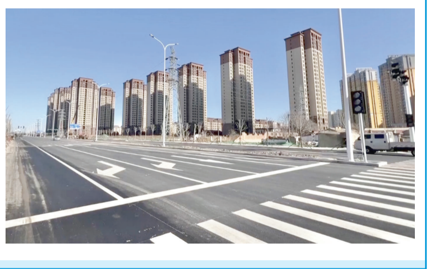
▼2024年9月,宁河区启动芦汉路延长线项目,历时3个月,长约200米、宽38米的双向六车道修建完成。近日,芦汉路延长线开通,有效缓解周边道路交通拥堵问题。 本报记者 孙立伟 通讯员 吕卫涛 李颖 摄
