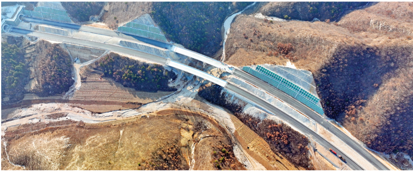
11月19日,由中国铁建投资集团投资建设、中铁二十局承建的凌绥高速公路4a标段最后一孔T梁架设完成,至此该标段桥梁架设全部完毕。凌绥高速公路建成后,将为辽宁省西部地区开辟一条新的出海通道,对改善辽西西部地区及内蒙古东部地区交通状况,振兴东北老工业基地,促进沿线地区资源开发和经济发展具有重要意义。
