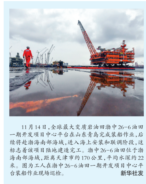
11月14日，全球最大变质岩油田渤中26-6油田一期开发项目中心平台在山东青岛完成装船作业，后续将赴渤海南部海域，进入海上安装和联调阶段，这标志着该项目陆地建造完工。渤中26-6油田位于渤海南部海域，距离天津市约170公里，平均水深约22米。图为工人在渤中26-6油田一期开发项目中心平台装船作业现场巡检。
