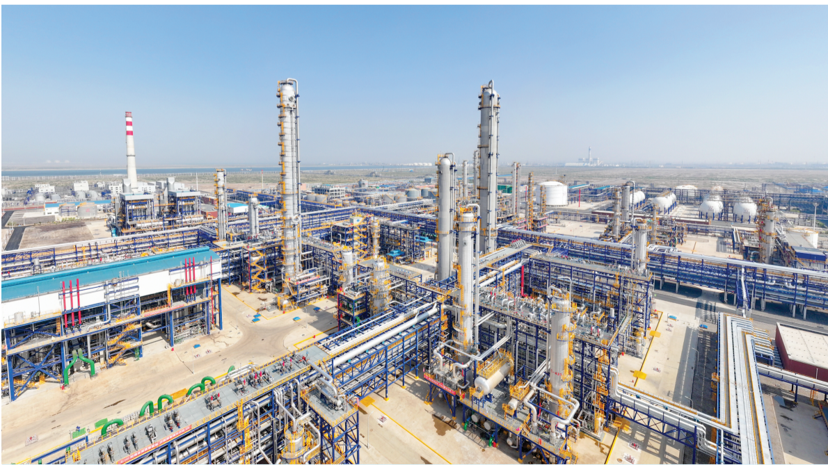
日前,天津南港120万吨/年乙烯及下游高端新材料产业集群项目一次开车成功并打通全流程,标志着中国石化天津基地的乙烯产能达250万吨/年,将带动千亿元级下游产业发展,每年可为下游提供高端化工产品和精细化学品原料400万吨。项目在国内首次实现乙烯装置与LNG(液化天然气)冷能耦合利用,并且打造了中国石化首个炼化基地绿色电厂,建成国内石化行业首家无人智慧实验室。 本报记者 王睿 赵建伟 摄影报道
