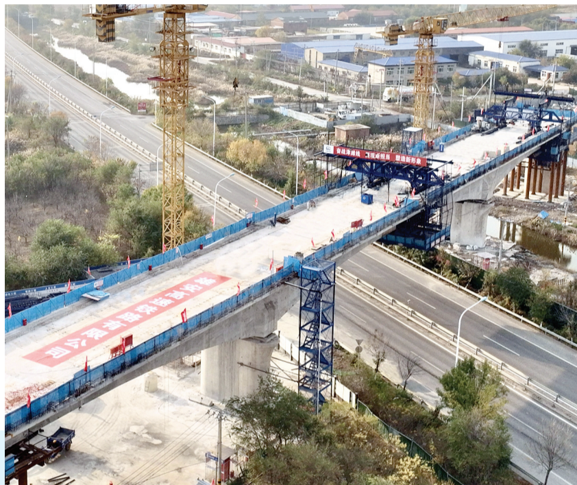
津潍高铁天津段首联连续梁合龙。 通讯员 侯晓静 本报记者 张磊 摄
